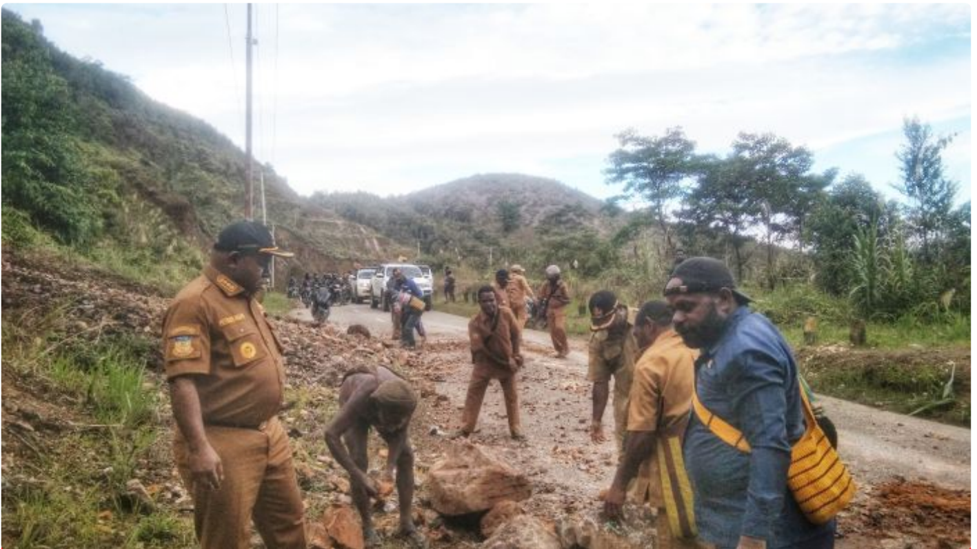
Rombongan Bupati sedang membuka Pemalangan Jalan Trans Papua di Odedimi antara Distrik Kamuu dan Distrik Kamuu Utara, Senin (17/7) - foto Aleks Waine
